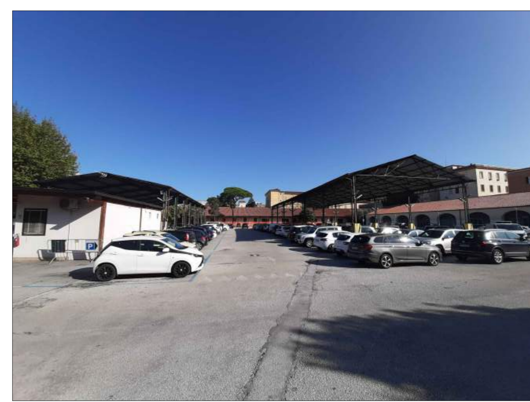
dett. STATO DEI LUOGHI Vista della "tettoia"
