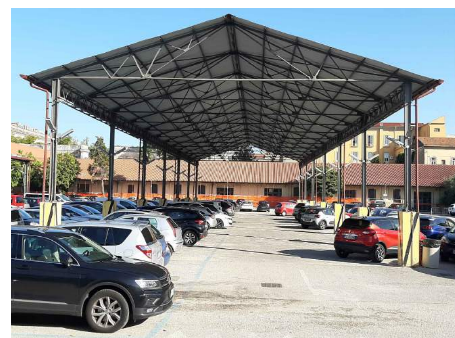
dett. "TETTOIA" grande Foto
