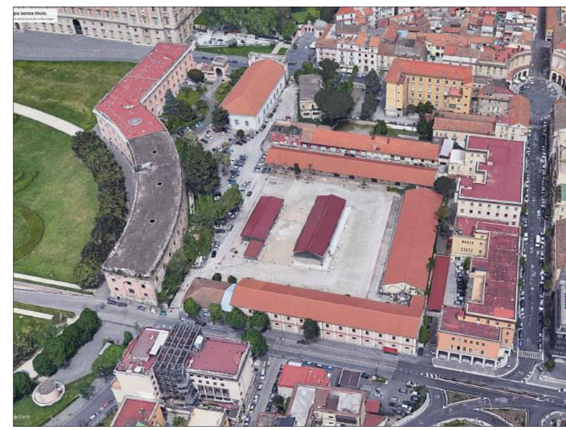
dett. AREA DI INTERVENTO Vista dall'alto
