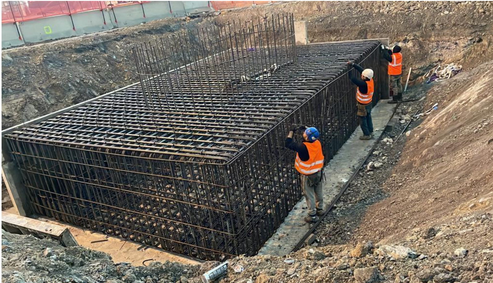
Realizzazione plinto di fondazione Sulmona (AQ)
