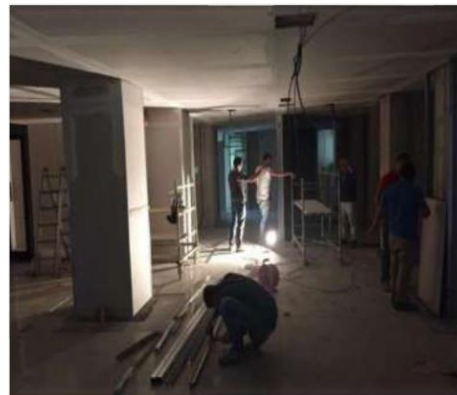
Lavori di ristrutturazione Boccia e Moda Santa Maria a Vico (CE)
